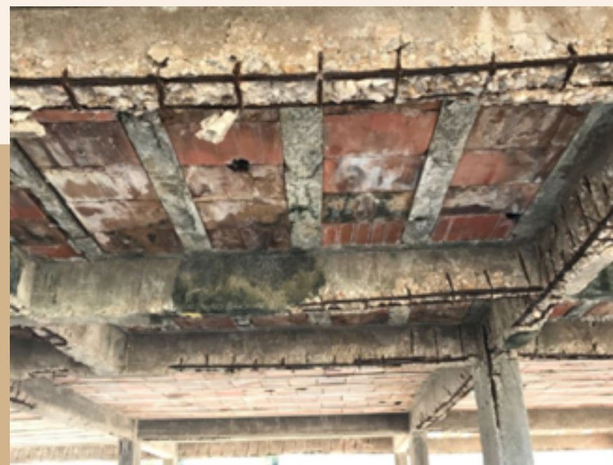
Imagem 2 -: Corrosão generalizada uniforme https://www.oitomeia.com.br/columas/engenheiro-marcos/2017/10/28/nas-praias-piauienses-casas-de-praia-sao-as-maiores-vitimas-da-corrosao/
