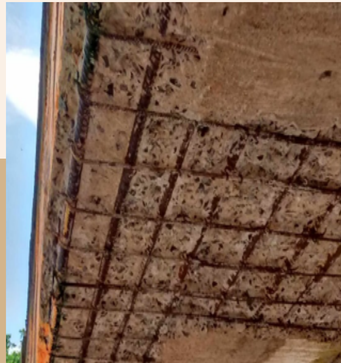
Imagem 8 - Corrosão generalizada: https://www.nucleodoconhecimento.com.br/engenharia-civil/recuperacao-de-estruturas
