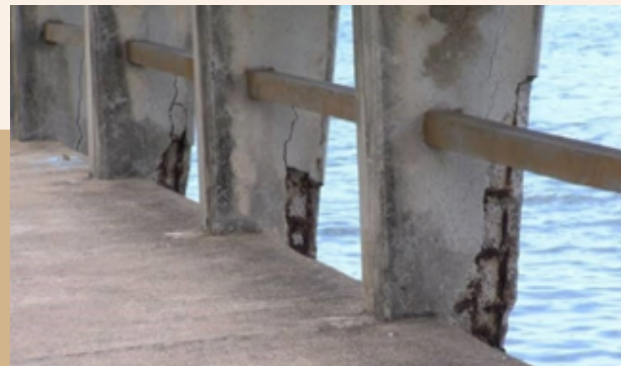
Imagem 6 - Guarda corpo de concreto corroídas por conta da maresia Disponível em: https://inbec.com.br/blog/inibidores-corrosao-tipos-principais-aplicacoes
