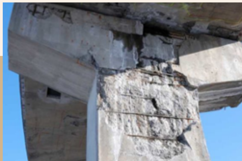
Imagem 1 -: Corrosão da armadura e deterioração do concreto que propiciam a instabilidade e a durabilidade da estrutura https://minapim.com/desvendando-a-corrosao/
