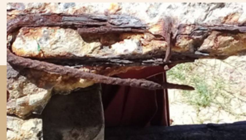
Imagem 3 - Aumento do volume causado pela crosta de ferrugem de uma armação causando a fissuração e deslocamento do concreto. https://inbec.com.br/blog/inibidores-corrosao-tipos-principais-aplicacoes
