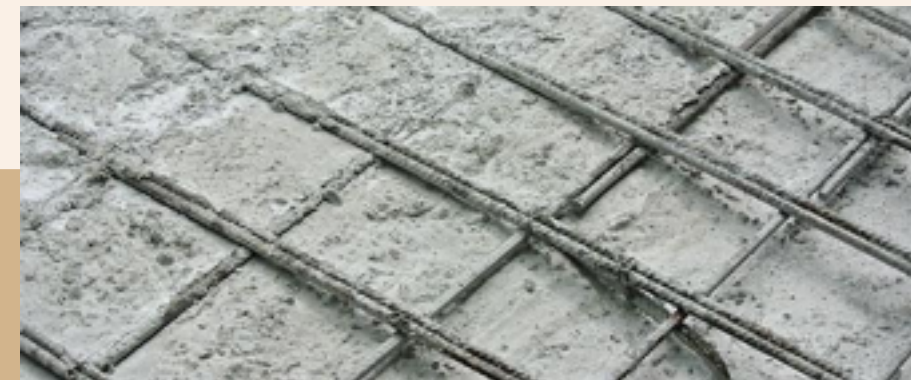
Imagem 5 - Lançamento de concreto sobre armadura de aço https://www.aecweb.com.br/revista/materias/vazios-de-concretagem-poem-em-risco-desempenho-de-estruturas-de-concreto-armado/14605
