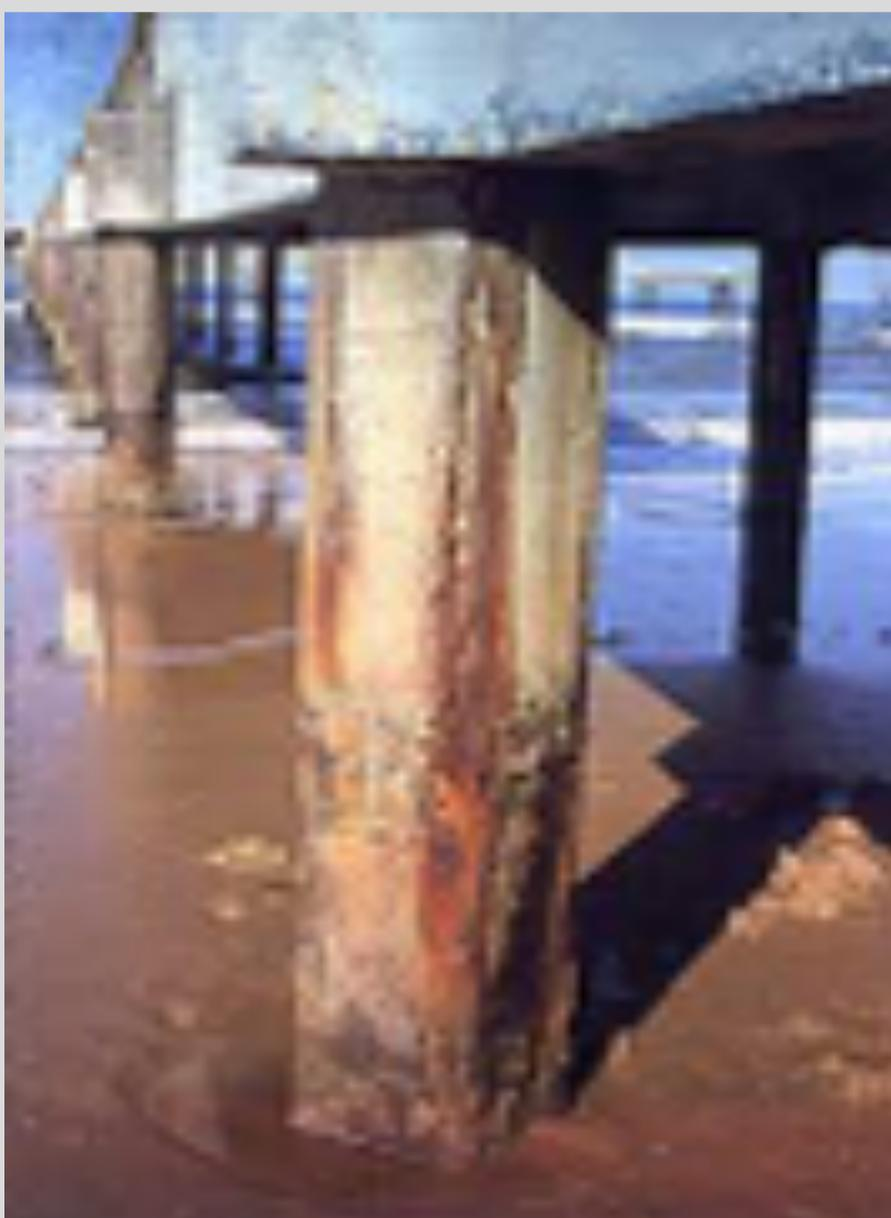
**Figura 01: Estrutura de Concreto sujeita a agressividade salina.**
