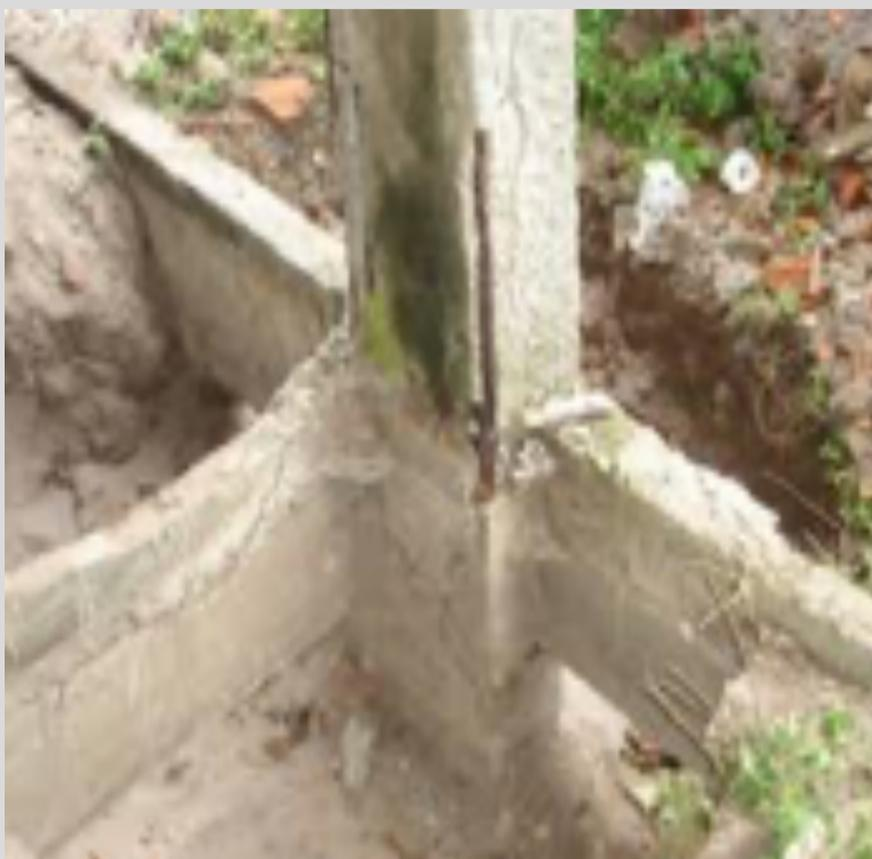
**Figura 03: Estrutura deteriorada por má execução.**
