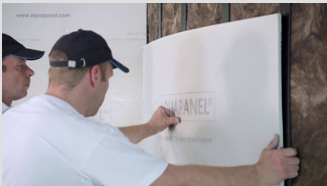
Imagem 5: Revestimento em parede curva por Aquapanel. Fonte: Sul Módulos .
