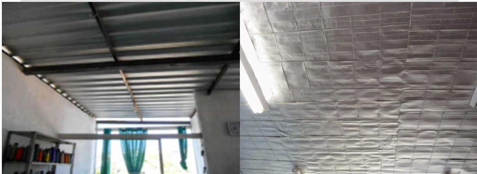
Figura 3: Telhado com revestimento painéis de Tetra Park. Fonte: MOURÃO et al., 2020.
