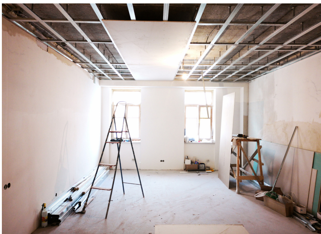
Imagem 2: Construção em dry-wall. fonte: Canva.
