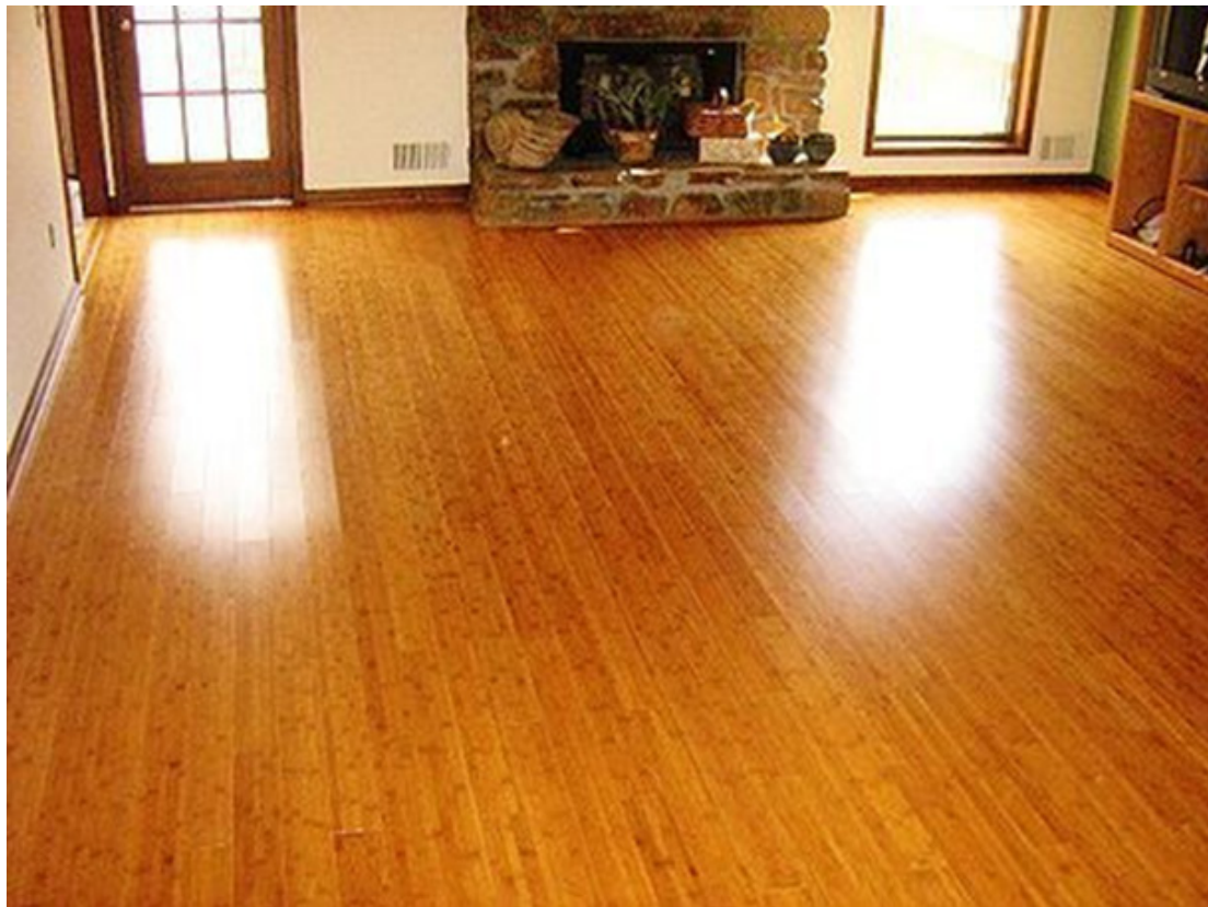
Imagem 2: O piso de bambu utiliza a espécie Mossô, uma das mais duras e fortes e que demora entre cinco e sete anos para amadurecer é mais resistente que os outros tipos de piso de madeira. Fonte: indiamart .
